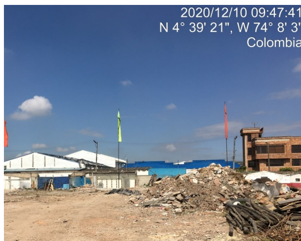
Fotografía 3. Material escombros-remanente para construcción
