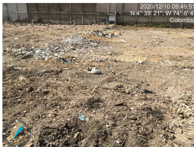
Fotografía 4. Suelo del área con relleno
